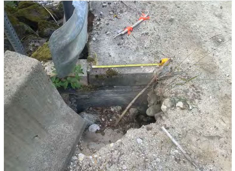
Eroding fill
